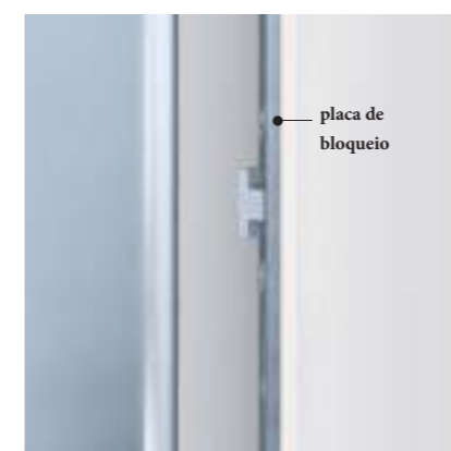
03 através da placa de bloqueio metálica ao fechar a porta
