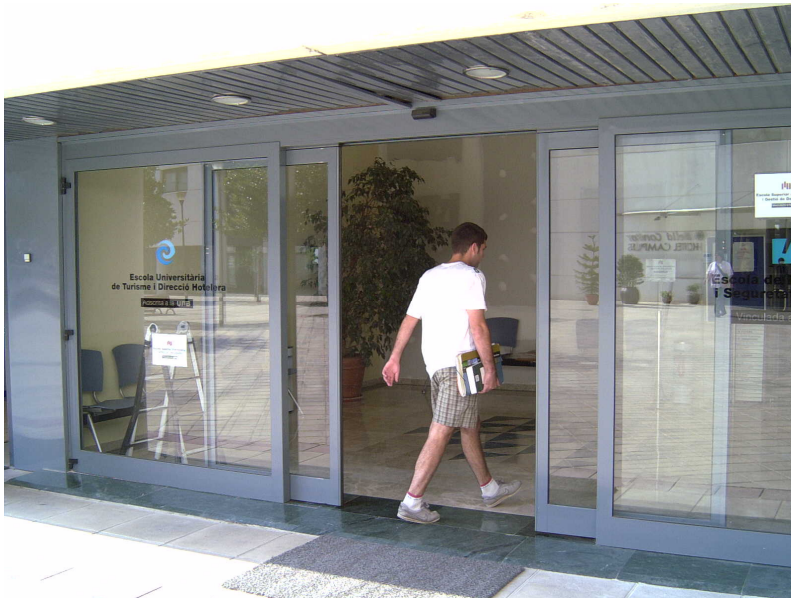
ANTIPÂNICO INTEGRAL (VIAS SAÍDA DE EMERGÊNCIA)
